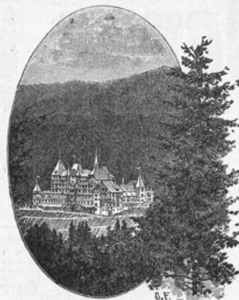
Hauptgebäude und Doktorhaus.
