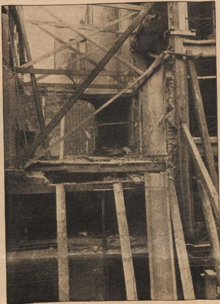
Die Wirkung unserer Zeppelingschüsse: Ein durch eine Bombe zerstörtes französisches Haus.
