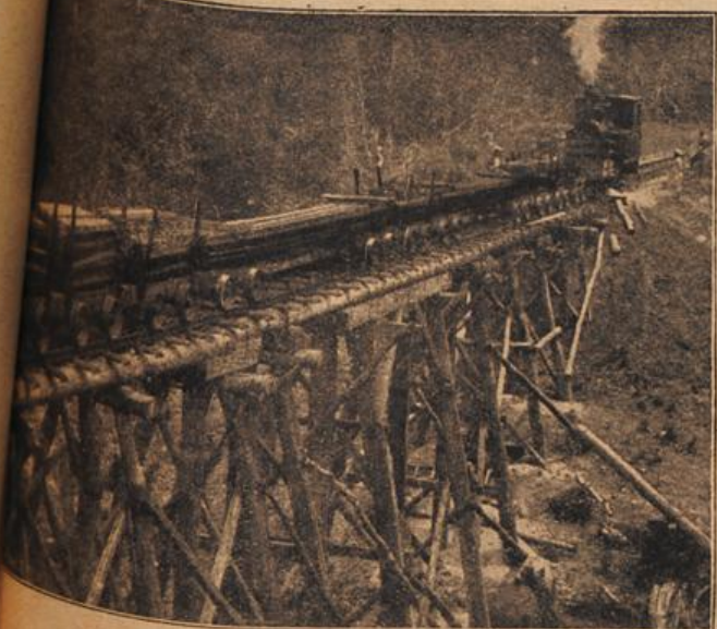
Oberbauzug auf der provisorischen Brücke.
