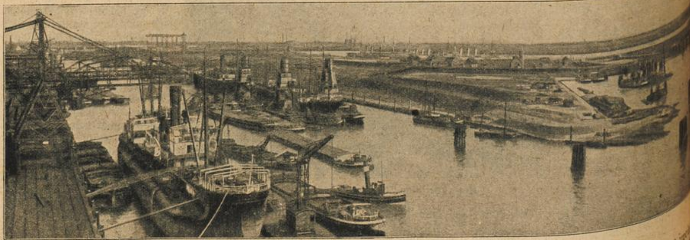
Der Außenhafen in Emden mit der neuen Seeschleuze. (Mit Text.)
