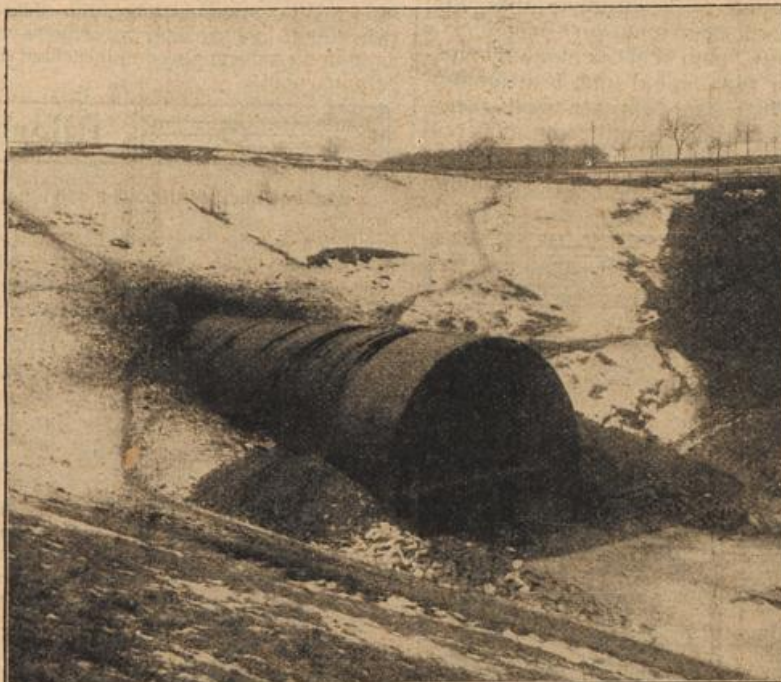
Durchstich des Disfetrasentunnels bei Schlüchtern-Fliesen. (Mit Text.)
