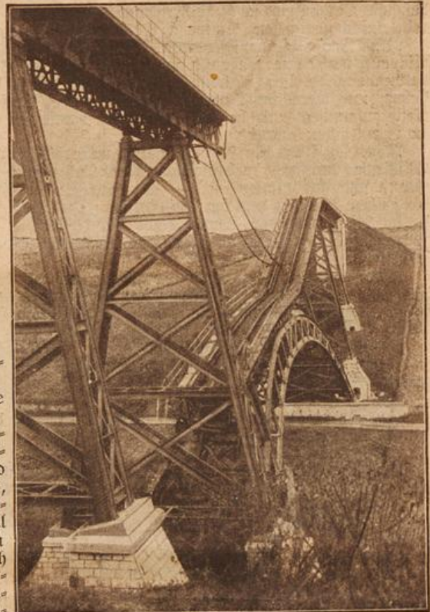
Zersprengte Eisenbahnbrücke bei Thiancourt-Foul. (Mit Text.)
