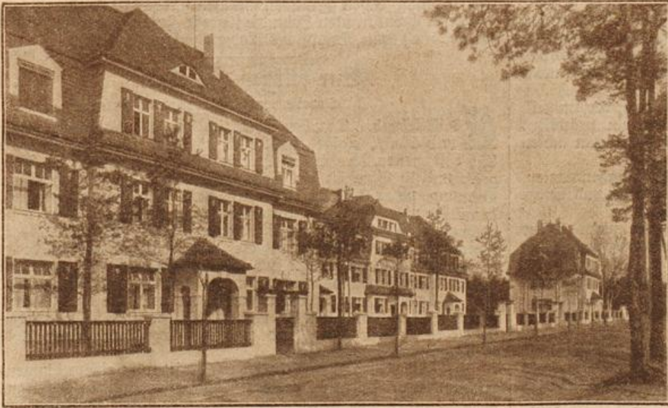
Die neuen Eisenbahnbeamtenhäuser in Coswig i. S. (Mit Text.)
