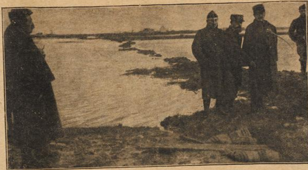
Ueberschwemmtes Land im Hsgerbiet.
