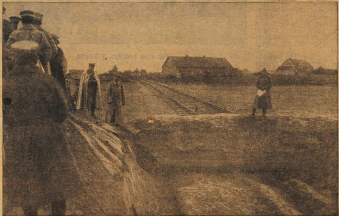
Erdgrube, in der ein 42-cm-Mörser stand, mit anschließendem Gleis zur Weiterbeförderung des Geschüßes.
