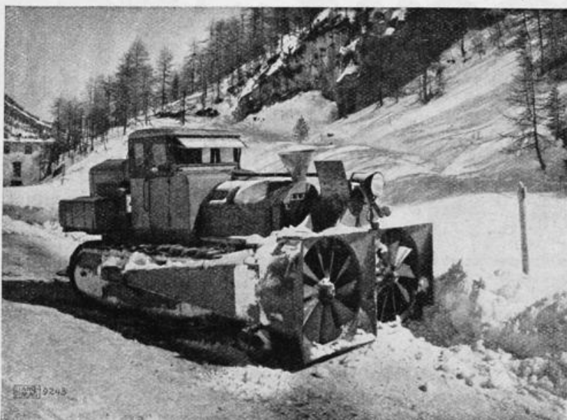
Der Hanomag-Kettenschlepper, umgebaut als Schneeschleuder
