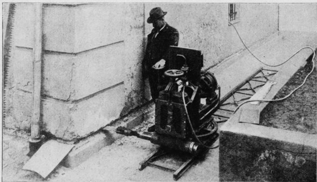
Die Mauer eines feuchten Hauses wird mit der elektrisch betriebenen Säge durchschnitten. Man sieht an der Ecke die Isolierungsplatte, die in die entstandene Fuge eingeschoben wird. (Industriebericht)
