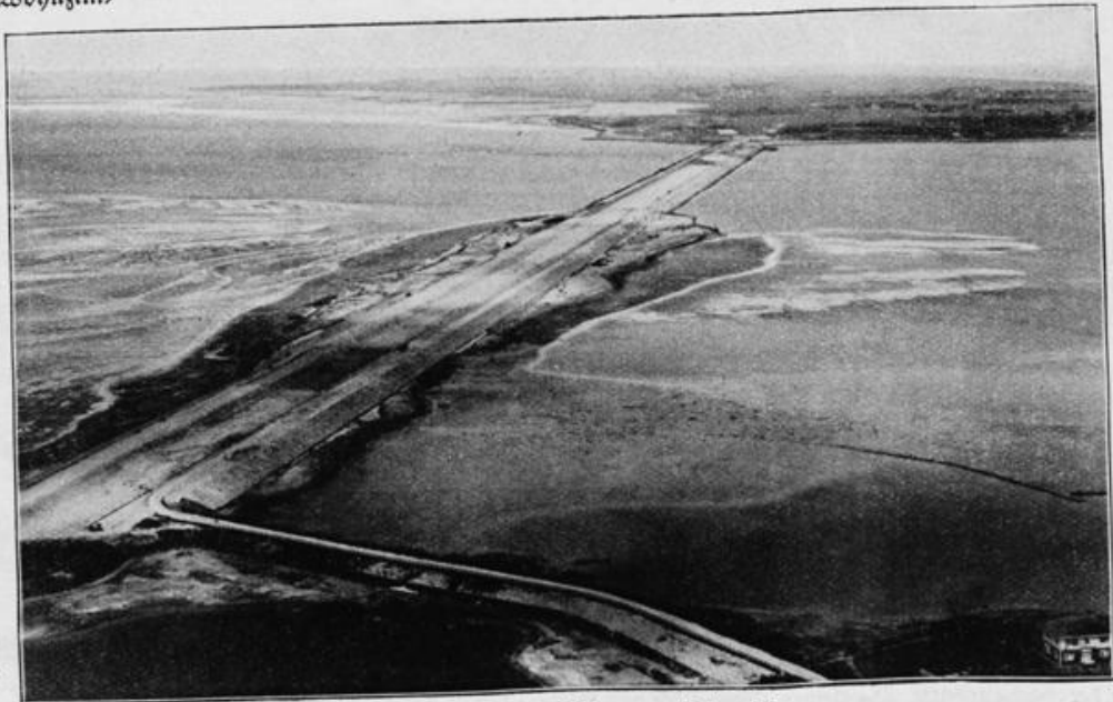
Dammbau in der Nähe von Medemblik
