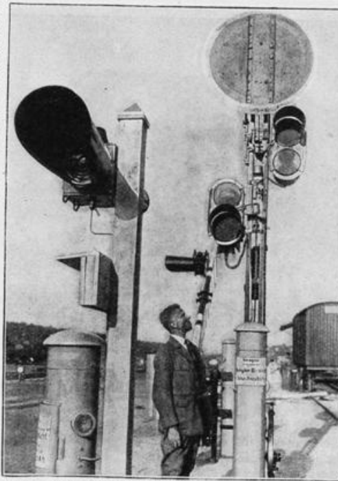
Eine neue Signalanlage für unsichere Bahnübergänge. Sobald die Züge sich auf tausend Meter dem Übergang nähern, werden weithin sichtbare Blinkzeichen ausgelöst. (A. B. C.)
