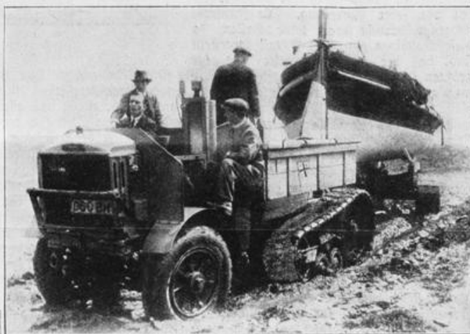
Automobile im Dienste der Schiffbrüchigen. Die englische "Gesellschaft zur Rettung aus Seenot" verwendet neuerdings zur Beförderung von Rettungsbooten mit gutem Erfolg Raupenschlepper. (Fotoaktuell)
