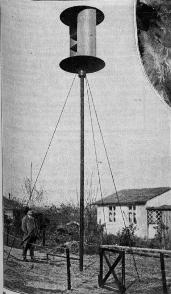
Pumpe mit Flettnerrotor, die täglich bei normalem Wind fünfzigtausend Liter Wasser fördert. (Pressephoto)
