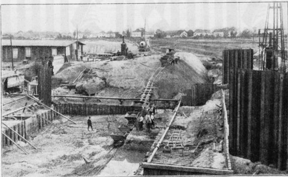
Vorarbeiten für das Wasserkraftwerk an der Schleuse Oldenburg
