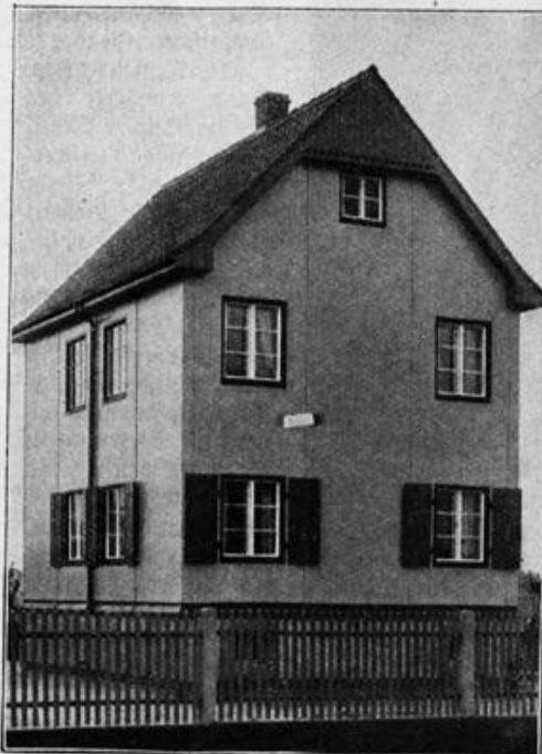
Modernes Stahlhaus: Siebelseite
