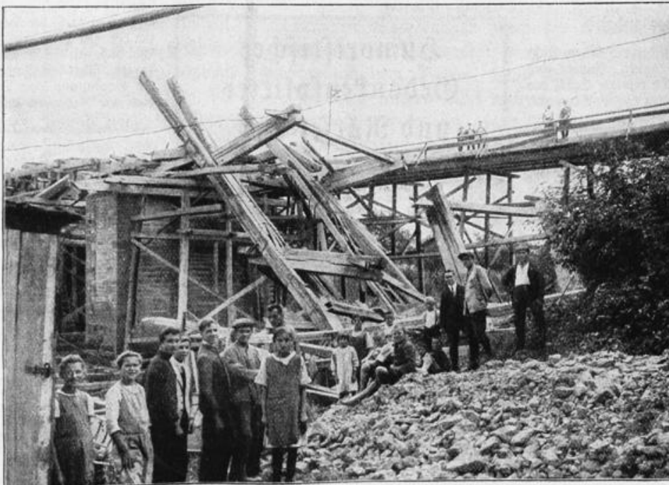
Der Brückeneinsturz bei Bessigheim am Neckar, der zum Glück kein Todesopfer forderte
