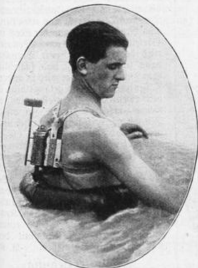
Ein neuer Rettungsgürtel. Zwei Wiener Mechaniker, Emil Hampeis und Karl Brunnbauer, erfanden einen neuen Schwimm- und Rettungsgürtel, der selbsttätig in Wirkung tritt und den Verunglückten in acht bis zehn Sekunden an die Wasseroberfläche befördert. (Atlantif)
