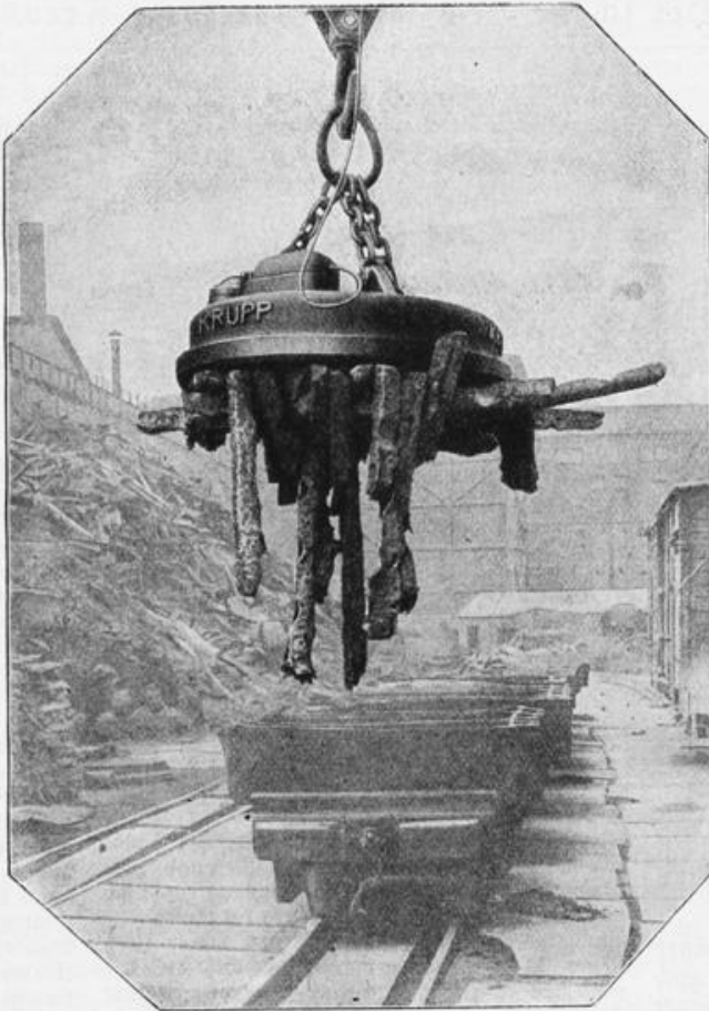
Unsichtbare Kräfte, die zentnerschwere Lasten befördern. Ein großer Elektromagnet, der zum Heben von Eisen, Schrot und so weiter in vielen Fabriken benutzt wird
