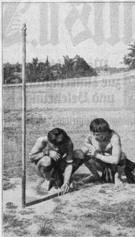
Bestimmung der am besten zur Aussaat geeigneten Zeit. Sie wird durch das Messen des Schattens festgestellt, den ein genau senkrecht aufgestellter Stab von bestimmter Länge zur Mittagszeit wirft
