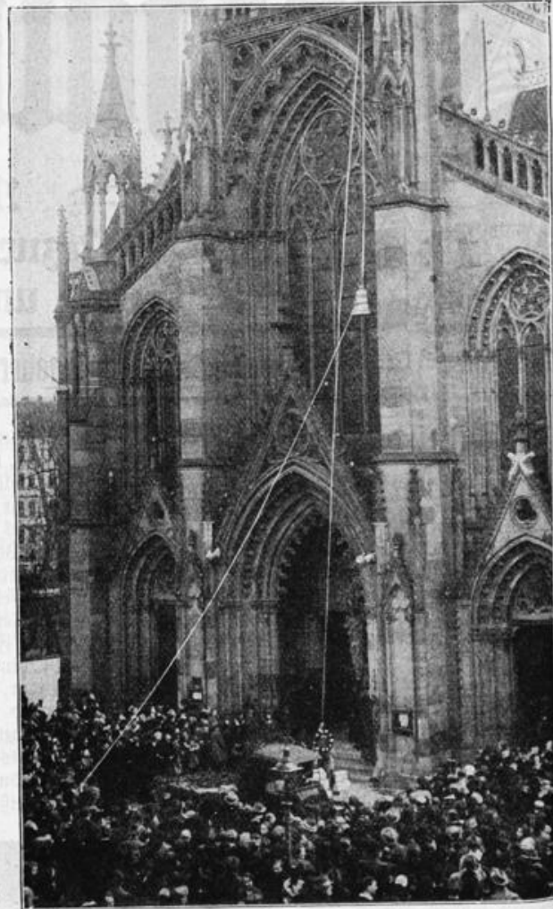
Eine neue Glocke wird zur Glockenstube emporgezogen
