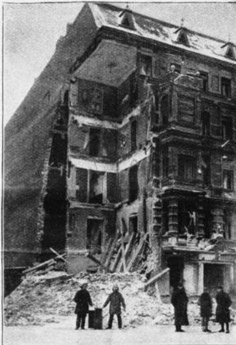
Das schwere Explosionsunglück in Berlin-Moabit, bei dem eine Anzahl Personen verletzt und mehrere getötet wurden. (Groß)
