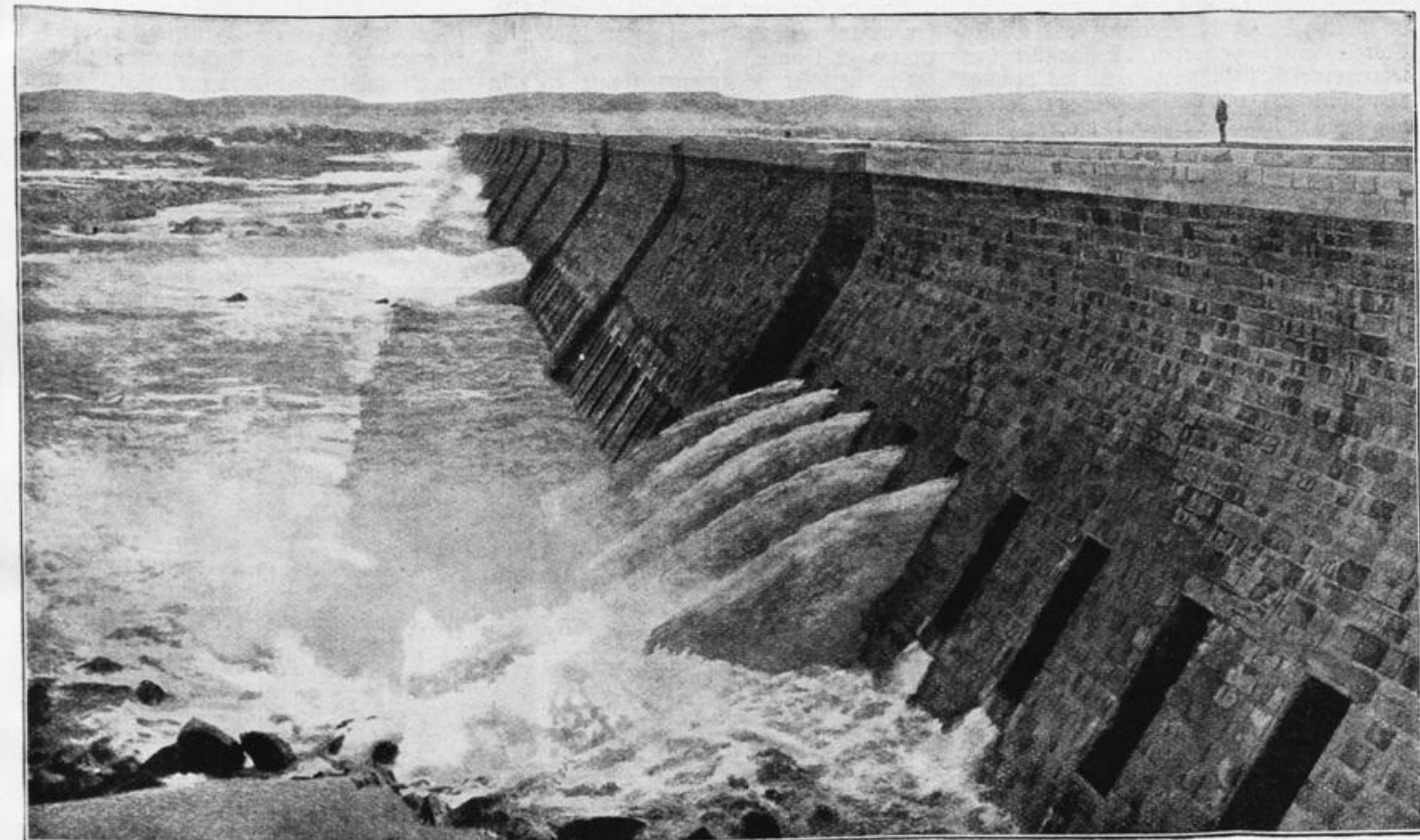
Der große Staudamm bei Assuan, eine der größten Stromsperren der Welt, über zwei Kilometer lang, mit hundertachtzig Schleusen. Nach seinem Vorbild wird am Blauen Nil eine neue große Nilsperrre erbaut. (Phot. Dittrich)
