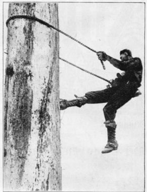
Lebensgefährliche Arbeit am Starkstrommast. (Pressphoto)
