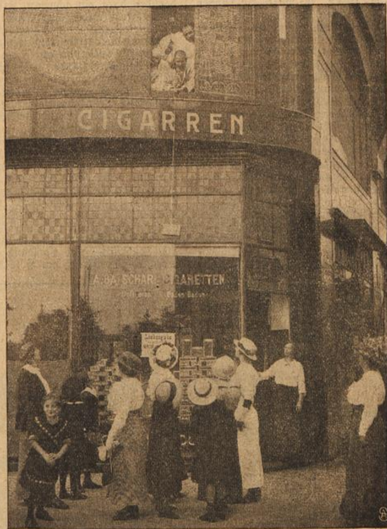
Die „Windfadenpost“ in Schöneberg. Beförderung von Liebesgaben-Zigarren an unsere Verwundeten von der Straße aus in ein im ersten Stockwerk gelegenes Kriegs-sanatorium.
