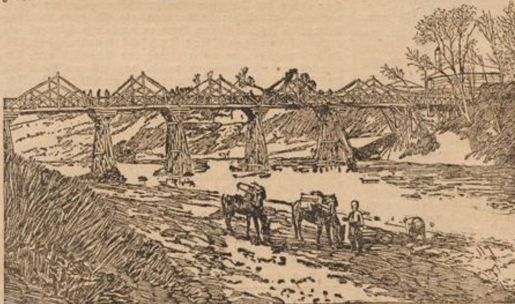
Die Brücke über den Aarsen-Fluss bei Bazar Schijak, der Mittelpunkt des Kampffeldes vor Durazzo.
