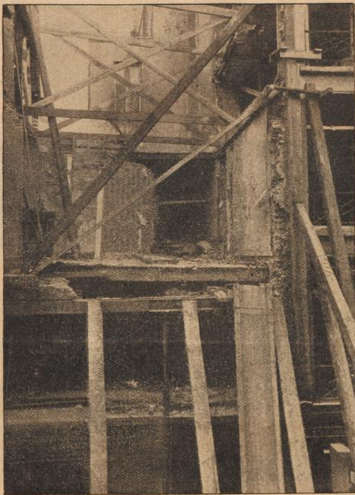
Die Wirkung unserer Zeppelingschüsse: Ein durch eine Bombe zerstörtes französisches Haus.
