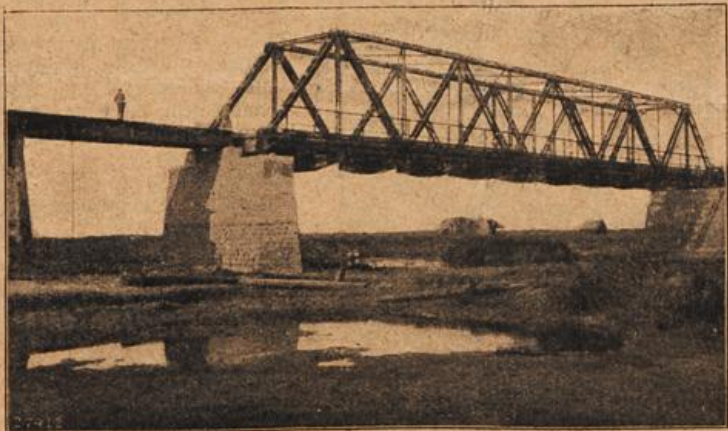
Brücke der deutschen Tanganjikabahn über den Mtagarassi-Fluß.
