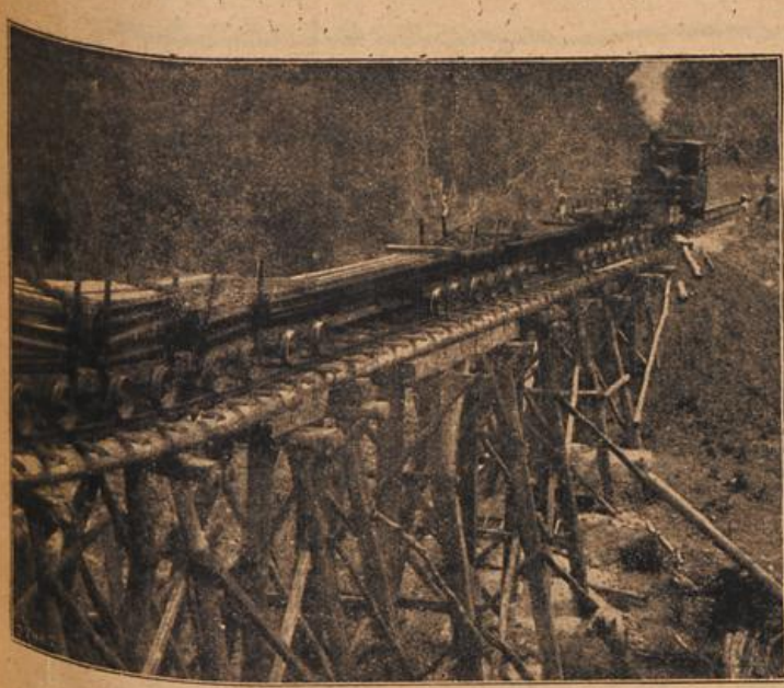
Oberbauzug auf der provisorischen Brücke.
