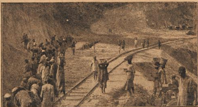
Erarbeiten für die Linienverlegung.
