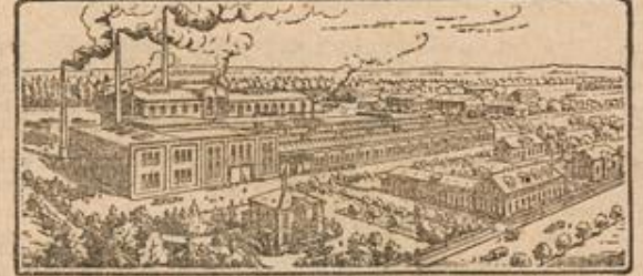
Buntfarben- und Chemische Fabrik, Al. Hehlen b. Celle
