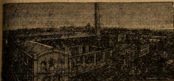
Freitragende Trägerwellblech-Dächer, Sheddächer, Färbereidächer und Trägerwellblech-Decken der Spinnerei, Weberei und Färberei von A. u. A. Lehmann, Niederschönweide b. Berlin.
