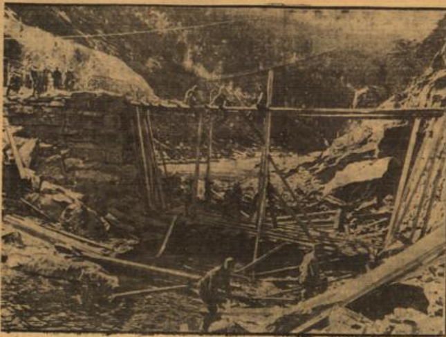
Unsere Wioniere beim Bau einer Notbrücke als Ersatz für die von den Norwegern zerstörte Brücke. (F.R.-Ebert-Weltbild, A.)
