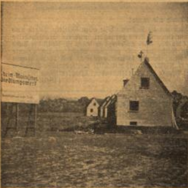
In Reih' und Glied stehen die Häuser. Im Rohbau sind sie bereits fertig.
