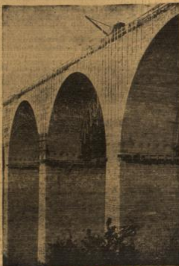
Kragende Pfeiler aus Stein und Beton.
