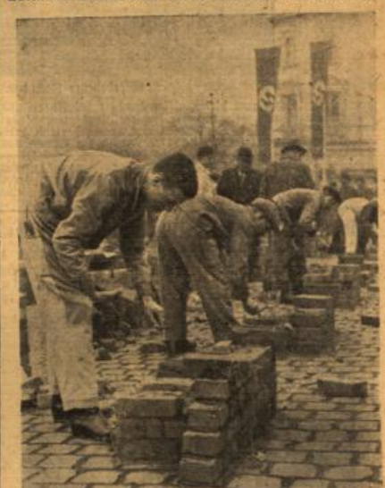
Der Frankfurter Opernplatz wurde zur Baustelle: im Vordergrund ein inner Wiesbadener Maurer bei der Arbeit.
