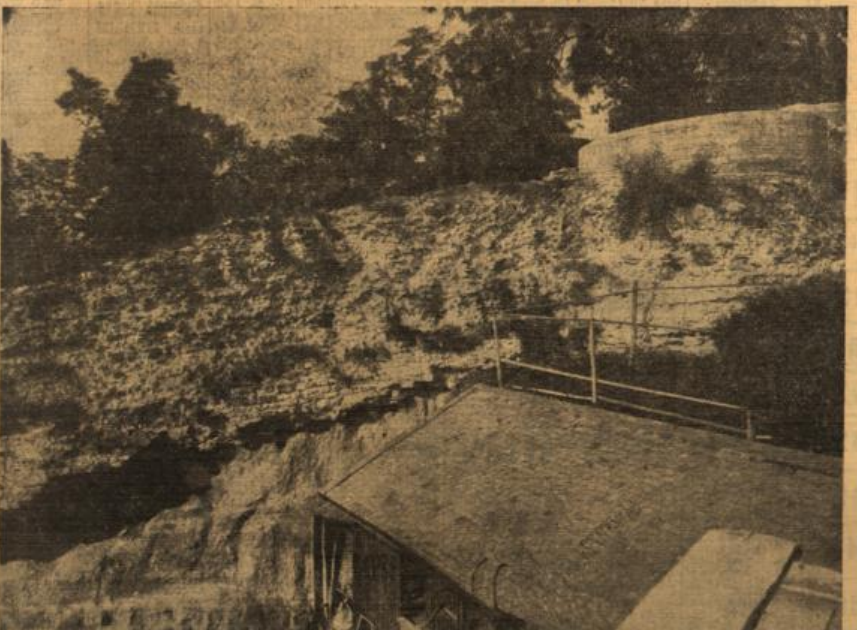
Der obere Teil der Heidenmauer mit dem Wehrturm vor Durchbruch der Kanalarbeit. (Photodokumentation Museum.)
