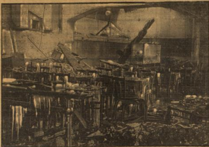
Der Zentralbahnhof von Utrecht durch Großfeuer zerstört.
