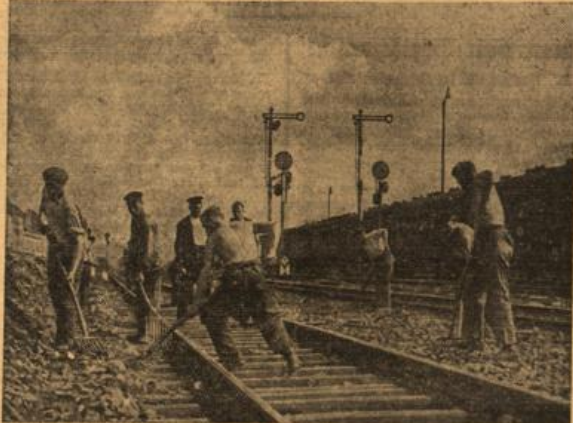
Werkarbeiter bessern den Oberbau eines Schienenweges aus.
