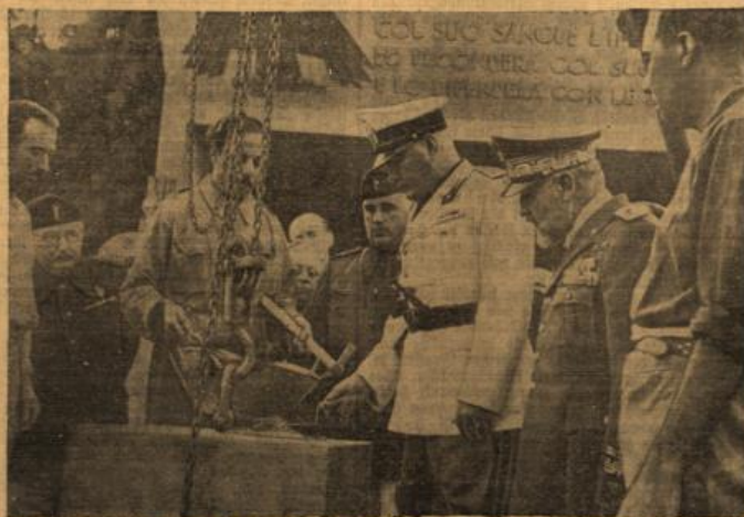
Mussolini legt den Grundstein zum Ministerium für Italienisch-Afrika. Der Duce während der Grundsteinlegung zu dem neuen Gebäude des Ministeriums für Italienisch-Afrika, das am Ende der Via dei Tritoni in Rom errichtet wird. (Rechtsbild R.)
