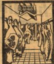
Fleischkühraum mit Frigidaire-Deckenkühlung
