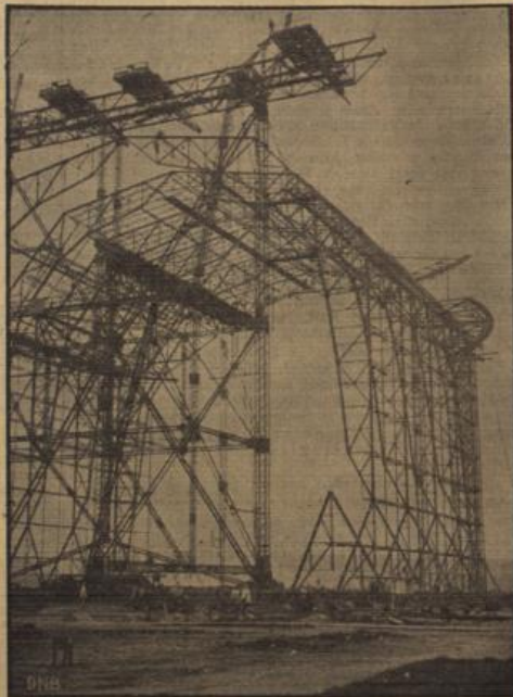
Neueste Aufnahme vom Bau der riesigen Luftschiffhalle auf dem Weltflughafen bei Frankfurt, von dem aus im kommenden Frühjahr der internationale Luftverkehr aufgenommen wird. Gigantisch regen die Pfeiler und Bogen in die Luft und lassen die ungeheuren Ausmaße der Halle nach ihrer Fertigstellung ahnen. (D.R.S.-Heimatbilderdienst, Photo: Schmidt.)
