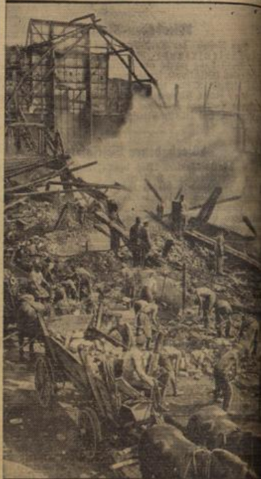
Während noch die Trümmer rauchen, räumen Arbeitsdienst und Militär den Schutt fort in den Boden für den sofortigen Wiederaufbau der Fernsehstationen. (Presse-Bild-Zentrale, N.)
