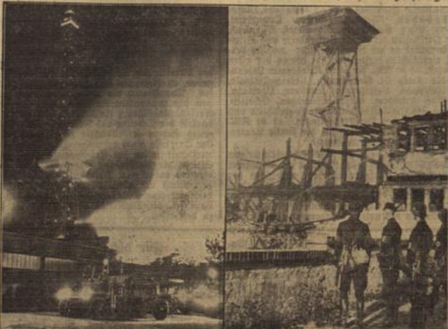
Das brennende Funkturm-Restaurant; rechts ein Ausschnitt von der ausgebrannten Halle 4. (Eberl-Bilderdienst, N.)
