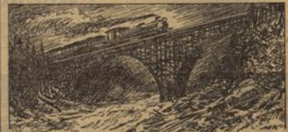
Über den Wildbach führt die Eisenbahnbrücke dahin.
