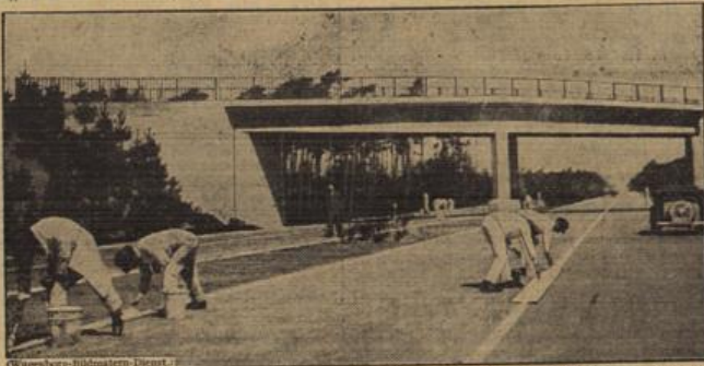
Bild auf die fertiggestellte Teilstrecke der Reichsautobahn Frankfurt am Main — Darmstadt.
