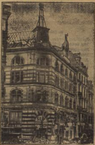
Das ausgebrannte Geschäftshaus.
