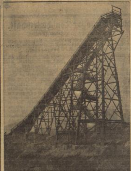
Die Sprunganlage für die Winter-Olympiade 1936, die bei Garmisch-Partenkirchen gebaut und kürzlich vollendet wurde.
