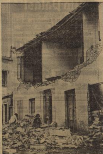
Durch einen Wirbelsturm zerstört wurde der griechische Ort Aifos, der zum großen Teil in einen Trümmerhaufen verwandelt wurde. Hierbei fanden vier Personen den Tod, während zahlreiche andere Einwohner Verletzungen erlitten.
