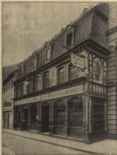
Das „Tagblatt-Haus“ nach seinem Umbau 1894.
