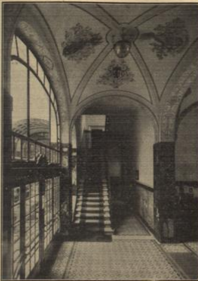
Treppenaufgang in der Durchgangshalle.
