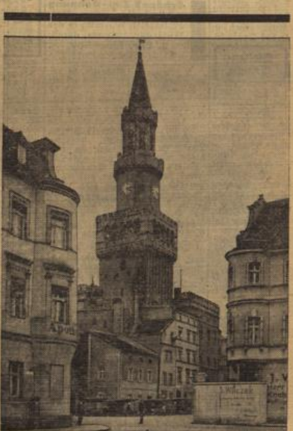
Der Turm des Doppelner Rathauses eingestürzt.
